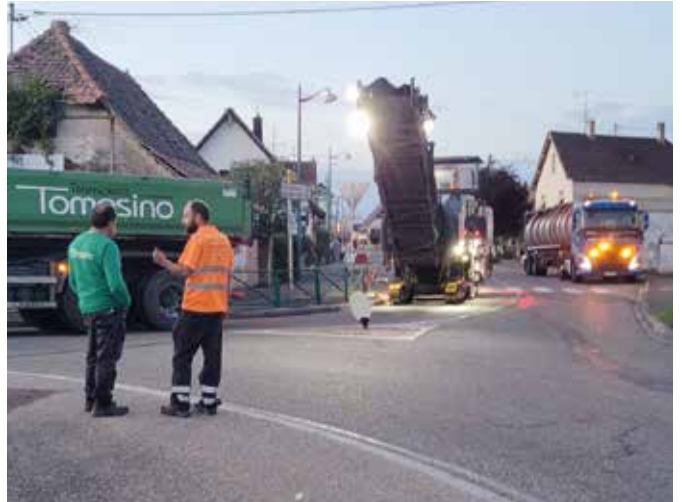
Réfection de la voirie autour du rond-point par la Collectivité européenne d'Alsace Juillet 2023.
