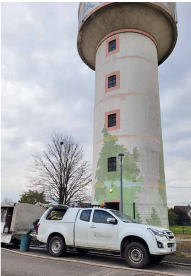
Nettoyage de la cuve du château d'eau par l'entreprise Aqua Maintenance basée à Fraize (88) Avril 2023.
