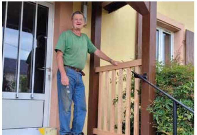
Remplacement du garde-corps de l'escalier du presbytère par l'entreprise Vonflie de Blodelsheim Juillet 2023
